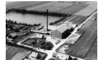
9 Der lange Arm der Pulverfabrik
