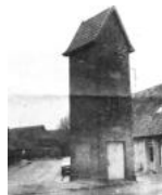
18 Transformatoren im Wandel der Zeit
